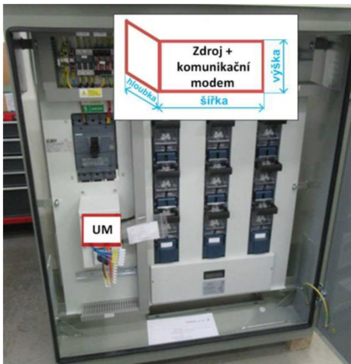
Obr. 1: Umístění měřicí sestavy v rozvaděči
